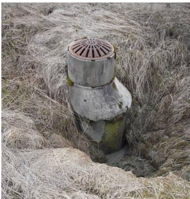
Kraftige nedbørepisoder kan gi erosjon og skader på det hydrotekniske systemet. (Foto: Atle Hauge)
