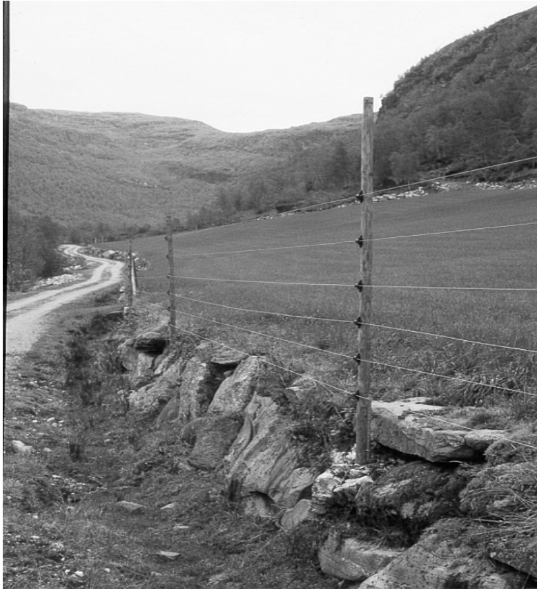
Figur 5. Eit nytt straumgjerde med seks straumførande trådar. Stolpeavstanden er ca. seks meter, og kanskje i lengste laget spesielt med tanke på snøpresset. Gjerdet er eit godt eksempel på korleis grøft/mur kan nyttast til å auke den effektive gjerdehøgda, og såleis redusere gjerdekostnadene.
