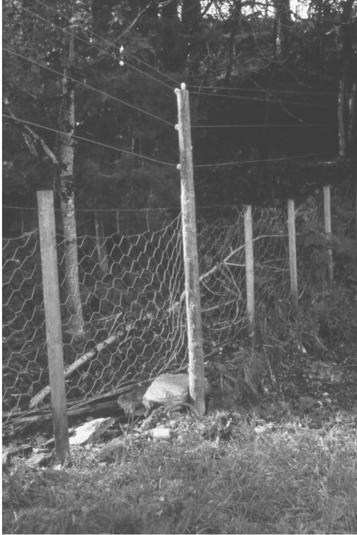
Figur 7. Terrengvariasjonar kan gjere det vanskeleg å halde gjerdet tett. Her har spennet i gjerdet dradd to av stolpane mest opp av jorda. Mellomrommet mellom nettingen og overtrådane har også blitt vel stort.
