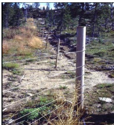
Rett, brei og flat trasé bør tilstrebes. Eksempel på riktig hjørne (foto: Ronald Bjøru).
